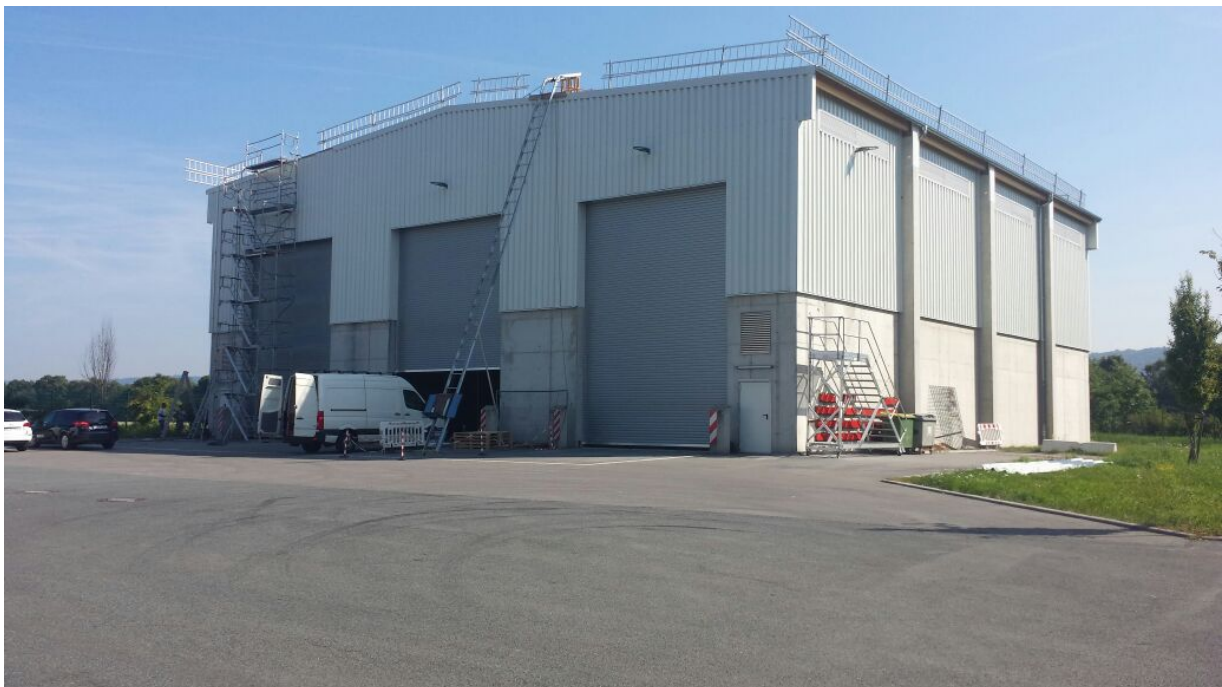
Bildunterschrift: Neue Umschlaghalle der AVR Anlage Hirschberg
