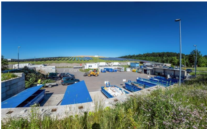
Bildunterschrift: AVR Anlage Sinsheim
